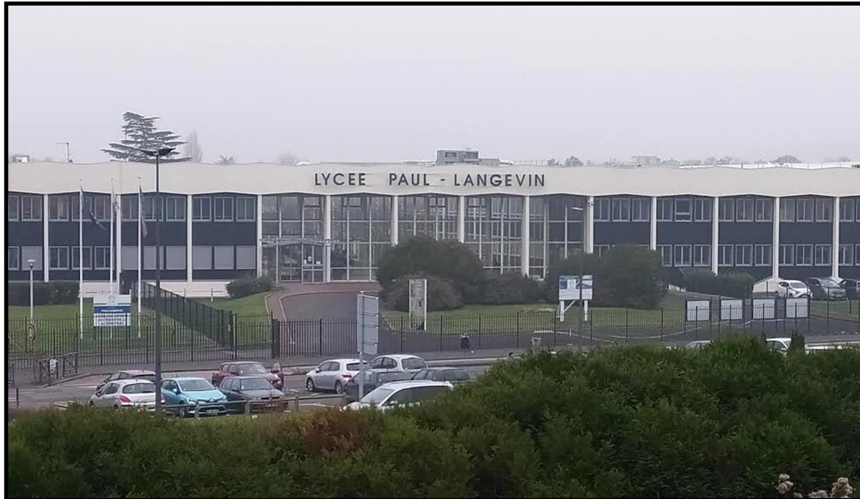
Lycée Paul Langevin – BEAUVAIS (60) Intégration GTB
