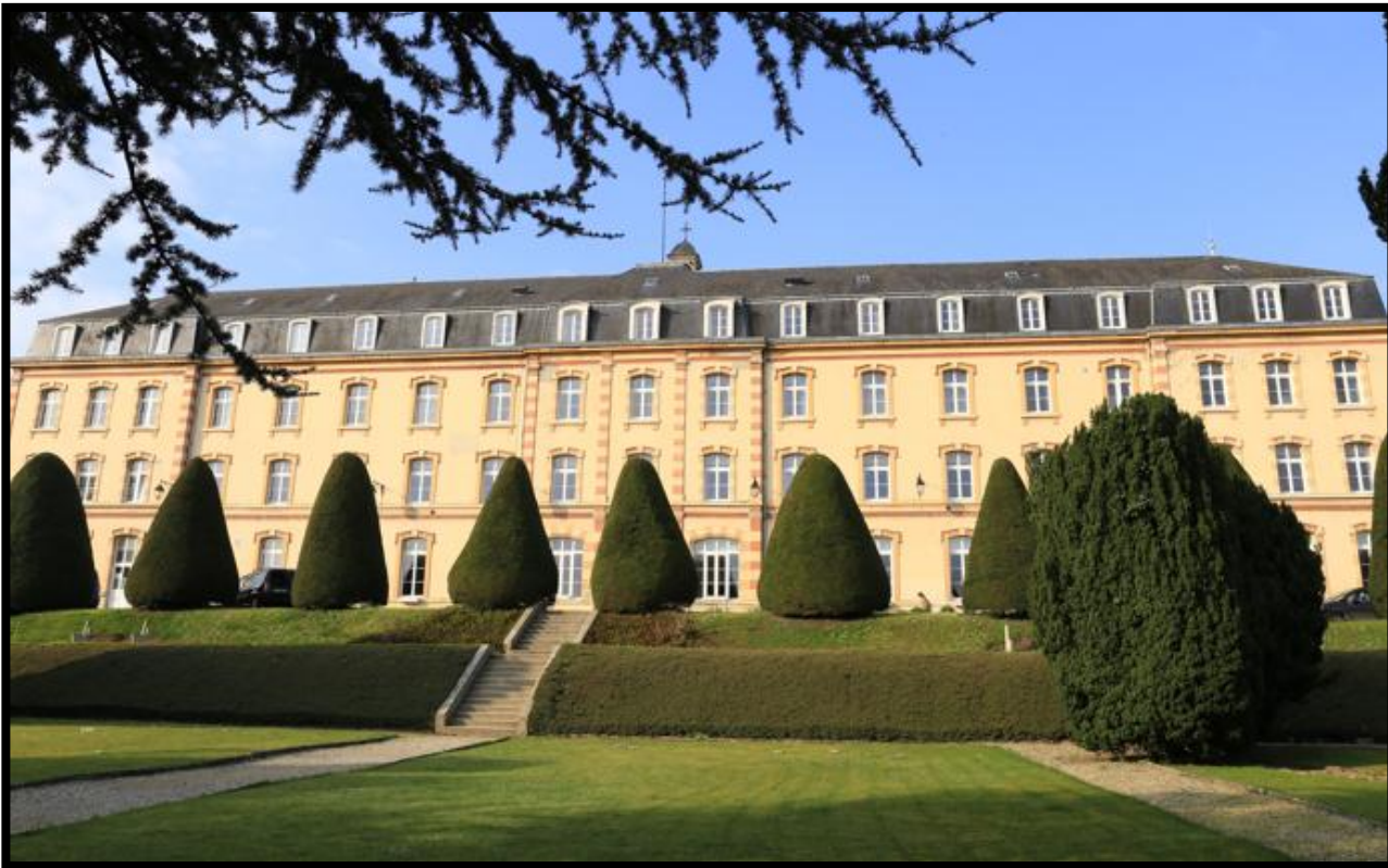
OGEC du Sacré-Cœur - REIMS (51) Gestion des éclairages et ouvrants KNX
