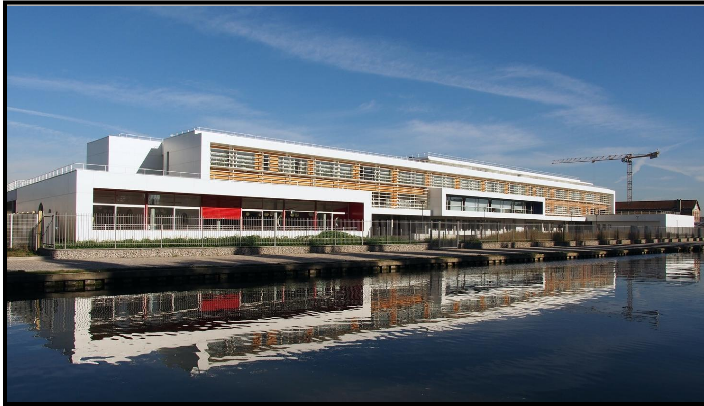
Collège Anatole France – LES-PAVILLONS-SOUS-BOIS (93) Gestion des éclairages KNX – CVC Modbus / Bacnet
